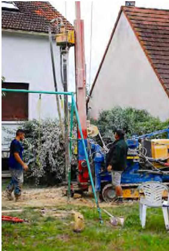
Géothermie verticale : forage à 25m de profondeur dans du calcaire poreux de bord de Seine
